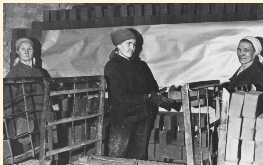
Ручная садка сырца в канал кольцевой печи №2
