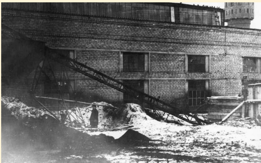
Линия подачи каменного угля на туннельные печи в цехе №1 с ручной погрузкой угля на конвейер
