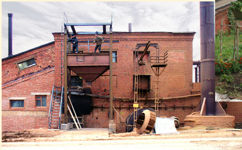
Монтаж аспирационной системы
