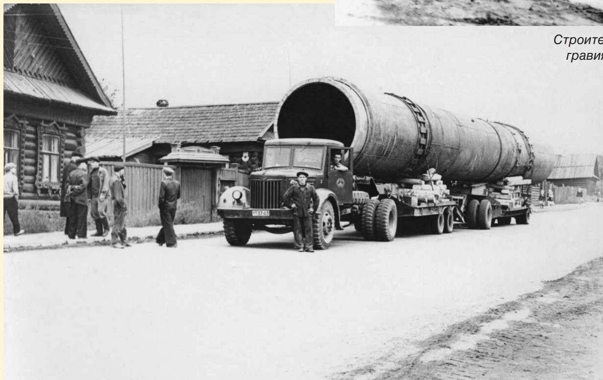
Транспортировка вращающейся печи для обжига керамзита на строительную площадку
