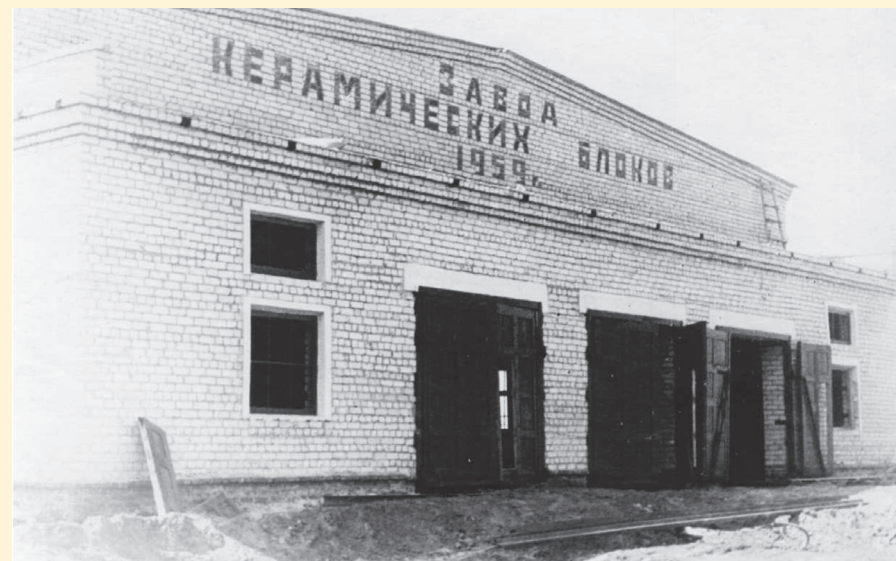
Завершается строительство корпуса печного отделения цеха №1
