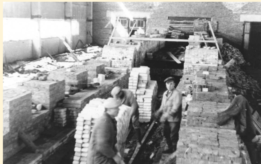
В новом корпусе печного отделения строятся две туннельные печи длиной 62 метра на газообразном топливе
