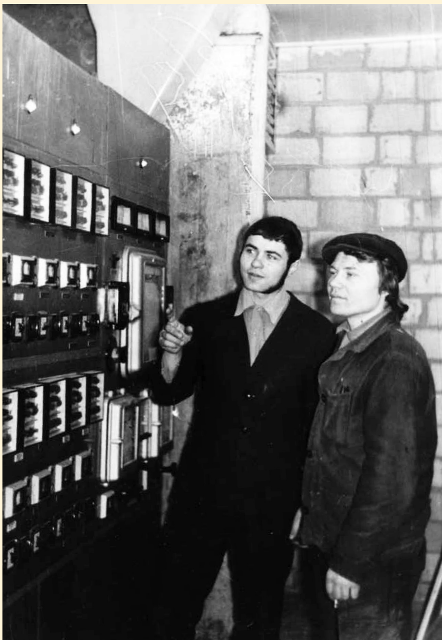
САРИК туннельных печей. Пуско-наладочные работы
