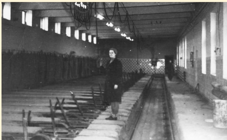
Туннельные сушила с канатными толкателями. Вид со стороны загрузки
