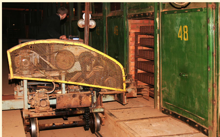
Загрузка реконструированных сушил с помощью самоходного электромеханического толкателя
