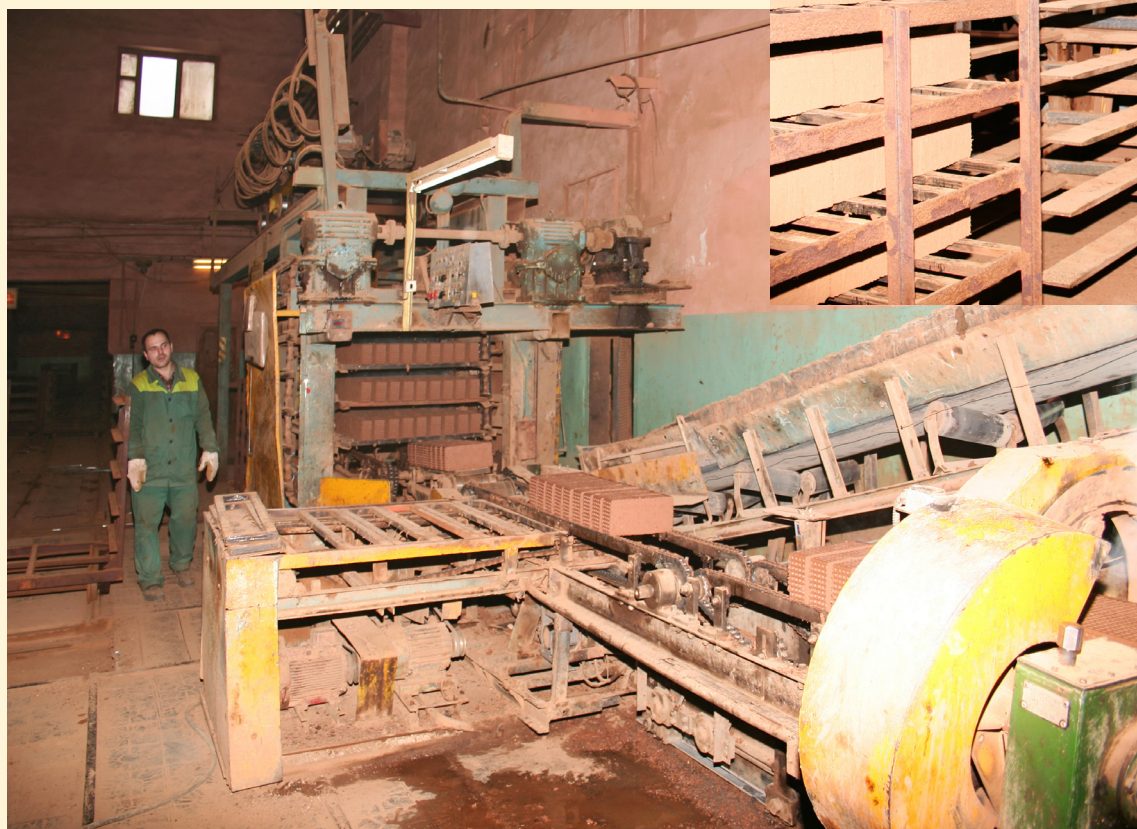
Формовочное отделение. Здесь выполнялась ручная съёмка и укладка сырца бригадой из пяти человек на сушильные вагонетки. Теперь эту работу выполняют автоматы-укладчики
