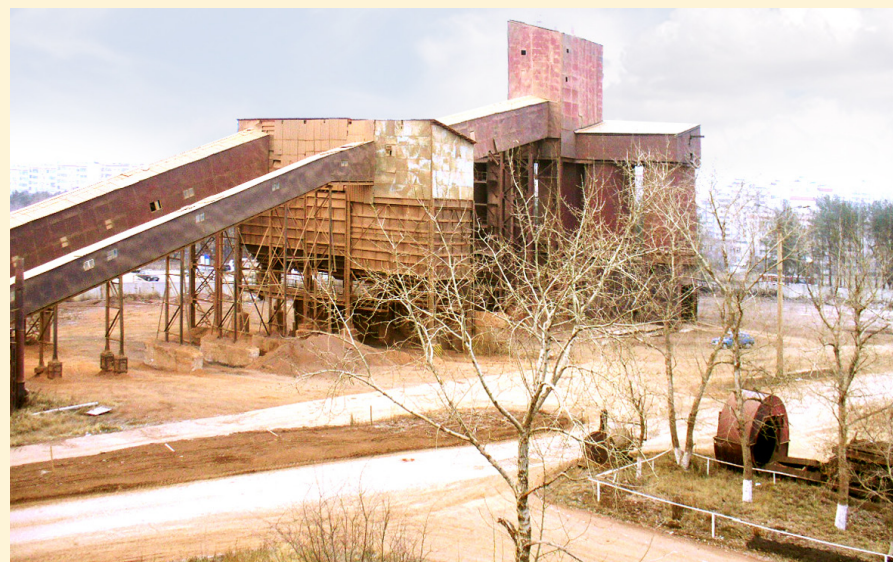
Складское хозяйство цеха после завершения реконструкции
