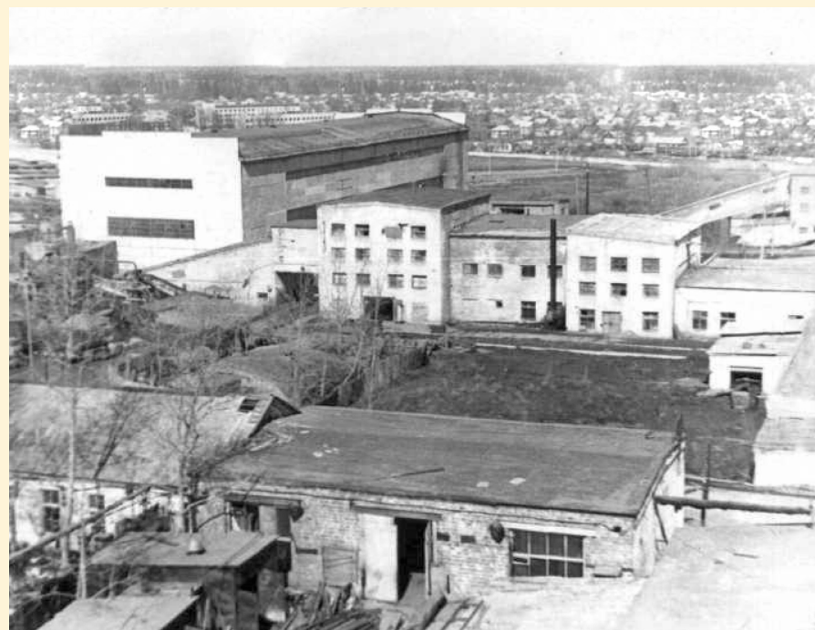
1970 год. Завершено строительство глинозапасника емкостью 11 тыс. м 3
