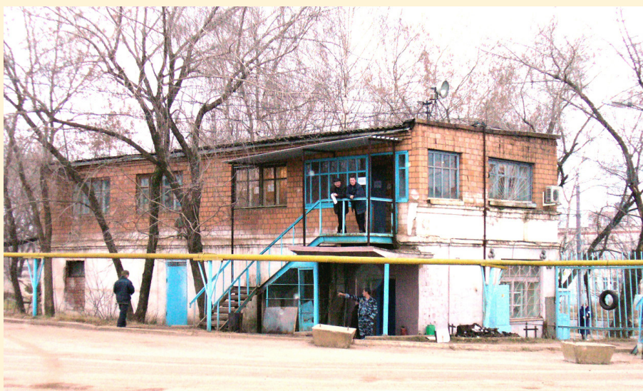
Старая проходная завода, надстроенная до двух этажей
