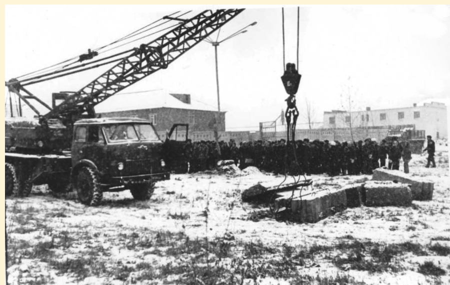
1976 год. Закладывается фундамент заводской столовой на 110 посадочных мест. Речь по поводу этого события произносит директор завода Юрченков Николай Михайлович
