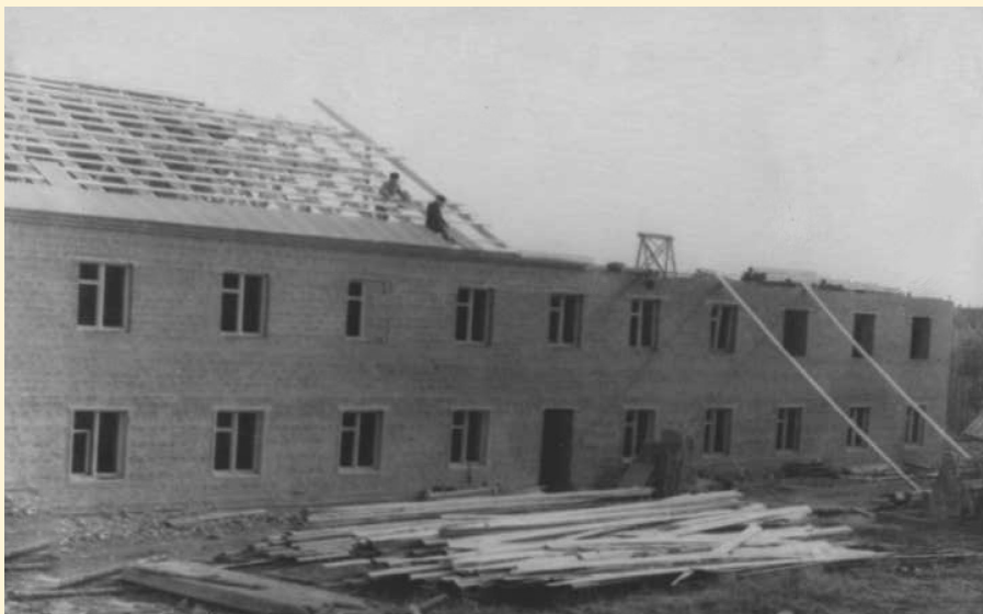
1968 год. Строительство двухэтажного общежития на 103 места
