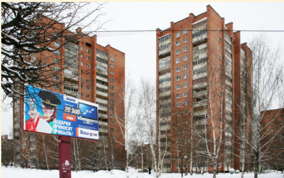
Группа жилых домов по ул. Горького
